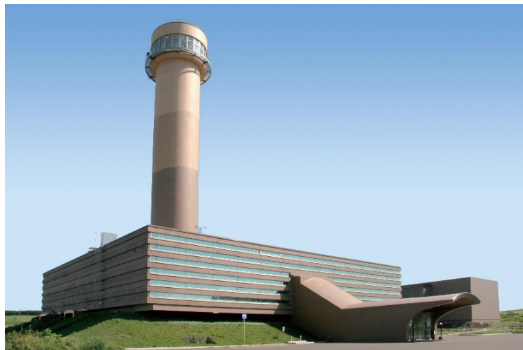
ゆめ地創館(平成19年6月30日開館)
