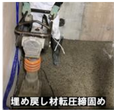
埋め戻し材転圧締め固め
