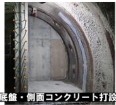
底盤・側面コンクリート打設
