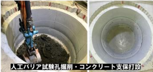
人工バリア試験孔掘削・コンクリート支持打設
