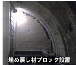
埋め戻し材ブロック設置
