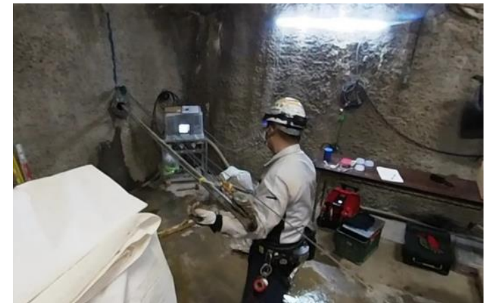
ボーリング孔閉塞試験 (ベントナイトブロックの充填作業)
