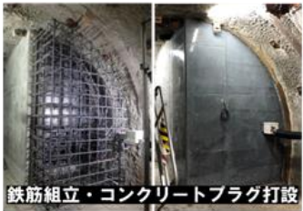
鉄筋組立・コンクリートプラグ打設
